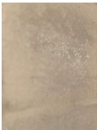
亜鉛メッキ製品表面に発生した白錆
