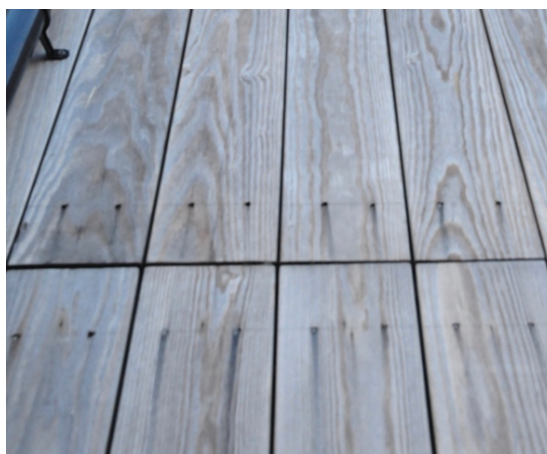
発生したビス周りの黒ずみ
