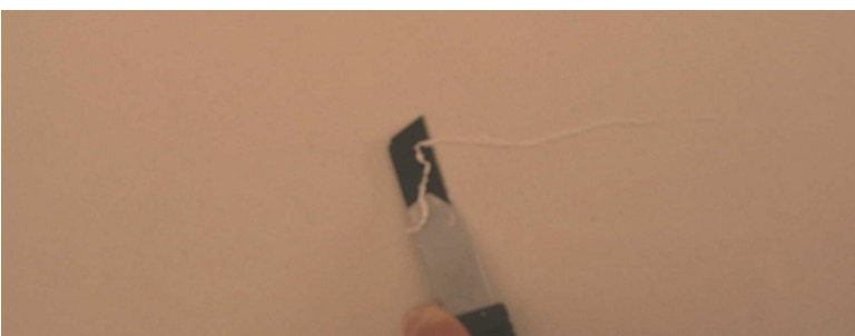
④ルマージュコークが硬化した後、カッターで削る。
