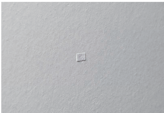
⑤軽く表面を触って確実に硬化している事を確かめる。
