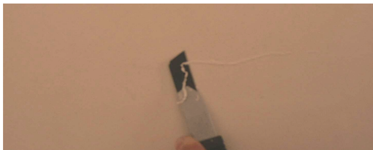
④ルマージュコークが硬化した後、カッターで削る。
