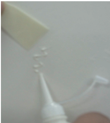
③凹部に対して、補修パテをヘラで少し盛り上がり気味に塗り付ける。(補修パテはできる限り塗り広げないこと)
