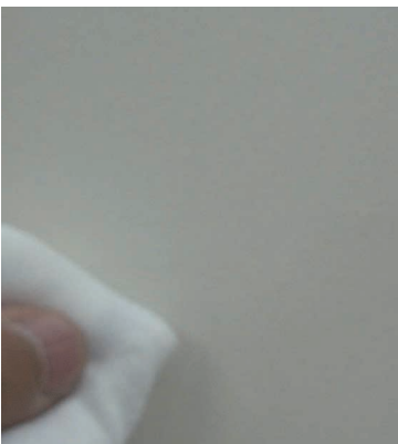
⑤サンドペーパーで削って艶の落ちた箇所を、乾いた白い布で擦って周辺と艶を合わせる。
