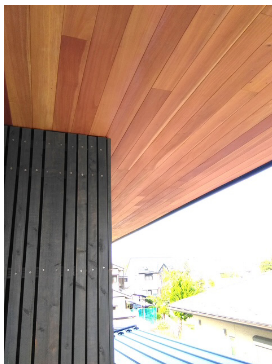
写真：屋外軒下施工
